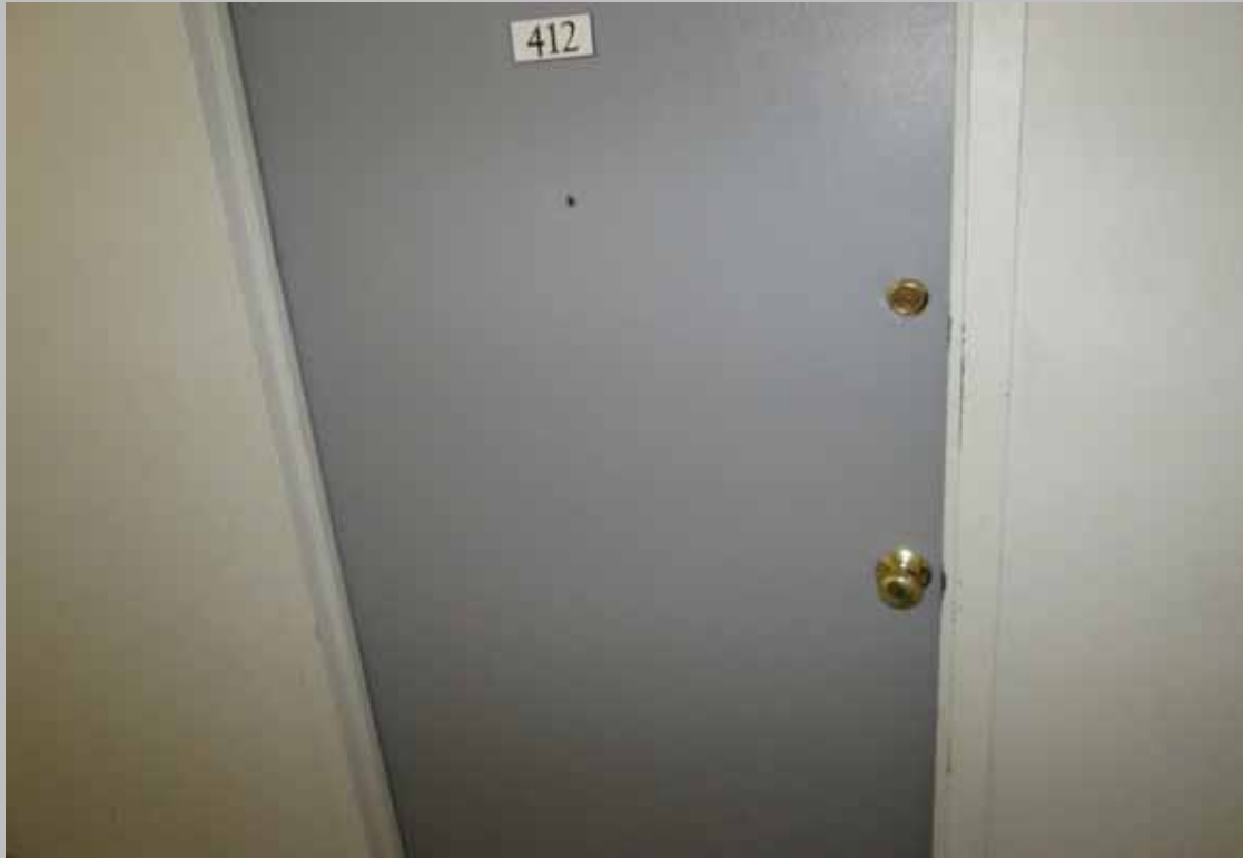
Dwelling unit door
