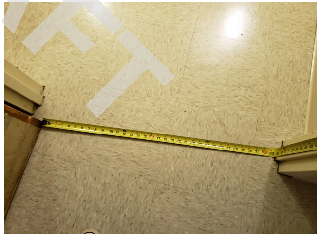
28. Unit 315- UFAS- 1bed/1bath- Bathroom- Door Width
